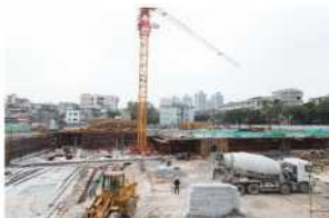
Рис 3.2 Мониторинг строительного шума
